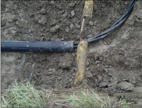
Kaapelilinjaa välillä Silvo - Kattelianmäki, Niemenpääntien varressa. Alituksen kohdalla tien pohjoispuolella paljastui kaksi aiempaa vierekkäistä kaapelikaivantoa, jotka kuvassa kulkeva kohtisuoraan. Kuvat länteen.
