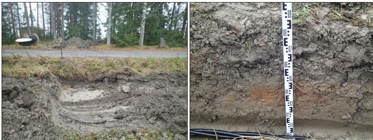
Vasen: Tien alituskohta Tonttimäen kalmistoalueen itäisen osan itäpuolella Niemenpääntien kohdalla. Kuva etelään. Oikea: Kaivanto Kattelianmäen länsipuolella Tonttimäen kalmistoalueen itäisen osan ympäristössä. Kaivannossa pohjoisseinämässä näkyy hajonnutta tiiltä.
