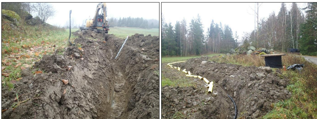
Maakaapelilinjaa Kattelianmäen länsipuolella Tonttimäen kalmistoalueen itäisen osan ympäristössä Niemenpääntien varressa vasemmassa kuvassa mahdollisen hautaröykkiön aluetta kuvassa vasemmalla kivikossa, hajonnutta tiiltä mitan ja lapion kohdalla. Länteen. Oikeassa kuvassa vasemman reunan tuntuun puiden ja kivien paikkeilla mahdollinen hautaröykkiön kohta. Itään.
