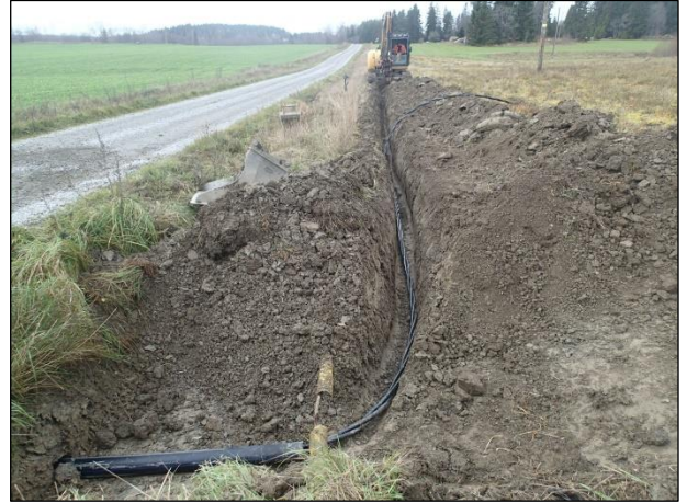
Kaapelilinjaa välillä Silvo - Kattelianmäki, Niemenpääntien varressa. Alituksen kohdalla tien pohjoispuolella paljastui kaksi aiempaa vierekkäistä kaapelikaivantoa, jotka kuvassa kulkeva kohtisuoraan. Kuvat länteen.
